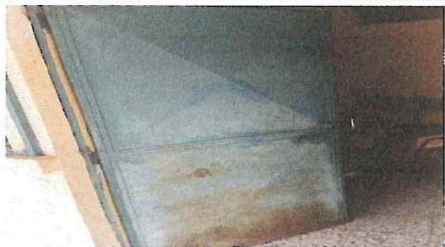
Foto 1: Mantenimiento a puertas de metal en aulas y cocina
