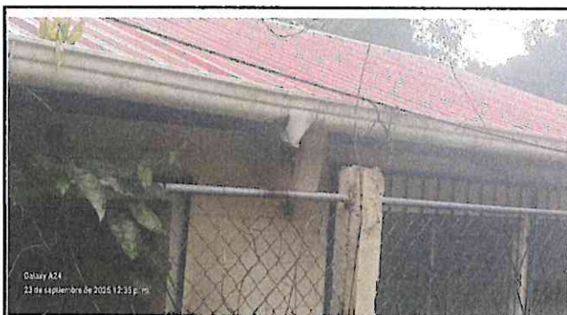
Foto 4: Sustitución de canales PVC
