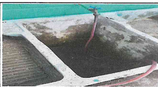
Foto 6: Sustitución de pila
