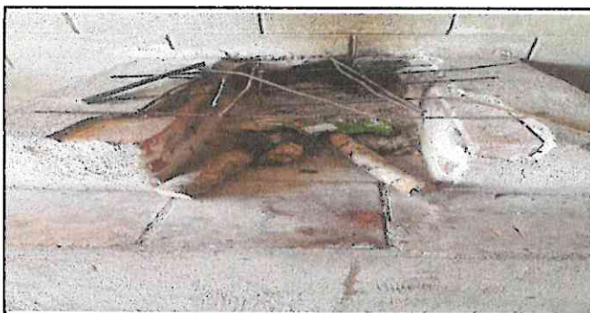
Foto 5: Reparación o sustitución de área de cocina
