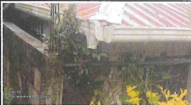
Foto 8: Sustitución de tubería PVC para agua potable
