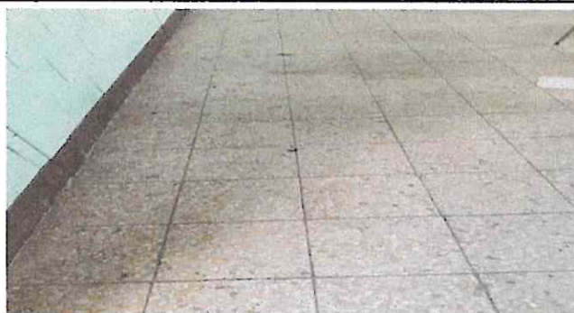
Foto7: Sustitución de piso cerámico
