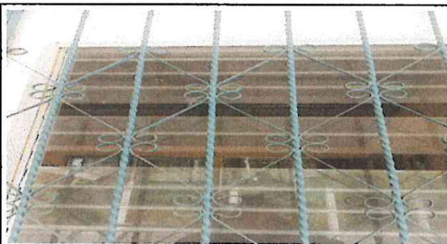
Foto 3: Mantenimiento de vidrios en aulas y cocina
